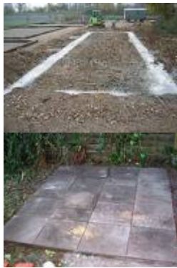
Streifenfundament
