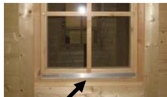
Alutropfschiene
