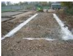
Streifenfundament
