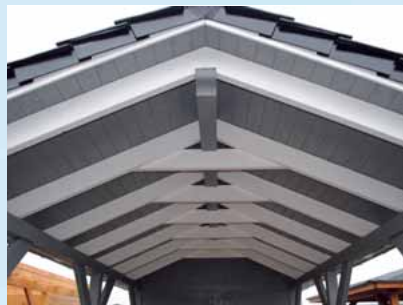
Ausführung, Dachkonstruktion, Carport
