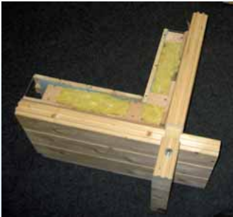
Wandaufbau für isolierte Häuser
