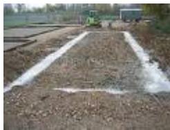
Streifenfundament
