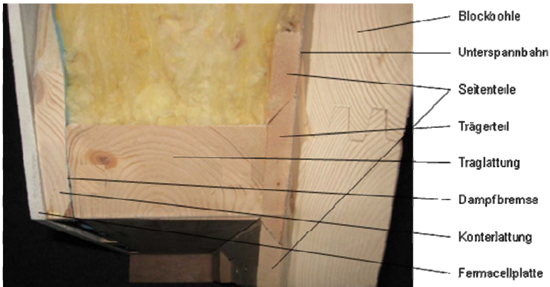
Bild: Schnitt durch isolierte Wand für Wohnhäuser, Innenverkleidung Fermacell
