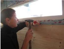
Anstelle der Faserplatten können Sie den Raum auch vertäfeln. Wir liefern i. d. R. Softline-Paneele, die die wunderschöne Optik der äußeren Blockbohlenwand in den Innenraum holen. Diese Paneele werden von unten nach oben verarbeitet, Federn oben liegend. Arbeiten Sie umlaufend mit einer Schattennut. D.h. Die Vertäfelung weist eine umlaufende Fuge zur Wand von ca. 1 cm auf.
