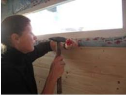
Anstelle der Faserplatten können Sie den Raum auch vertäfeln. Wir liefern i. d. R. Softline-Paneele, die die wunderschöne Optik der äußeren Blockbohlenwand in den Innenraum holen. Diese Paneele werden von unten nach oben verarbeitet, Federn oben liegend. An der Decke arbeiten Sie bitte mit einer Schattennut. D.h. lassen Sie zu den umlaufenden Wänden ca. 1 cm Abstand.
